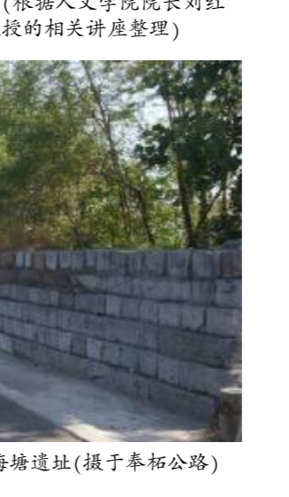
图片右侧即为华亭古海塘遗址(摄于奉柘公路)
